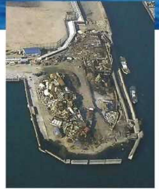
▲進徳丸解体撤去
